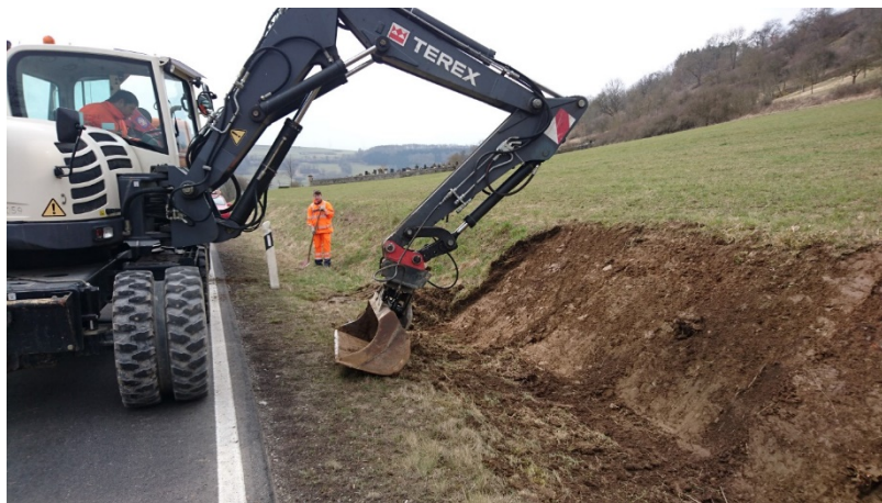
Foto 17 Abzogener Oberboden; Foto: Straßenmeisterei Künzelsau
