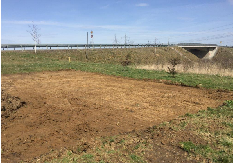
Foto 13 Abgezogener Oberboden; Foto: Straßenmeisterei Leonberg
