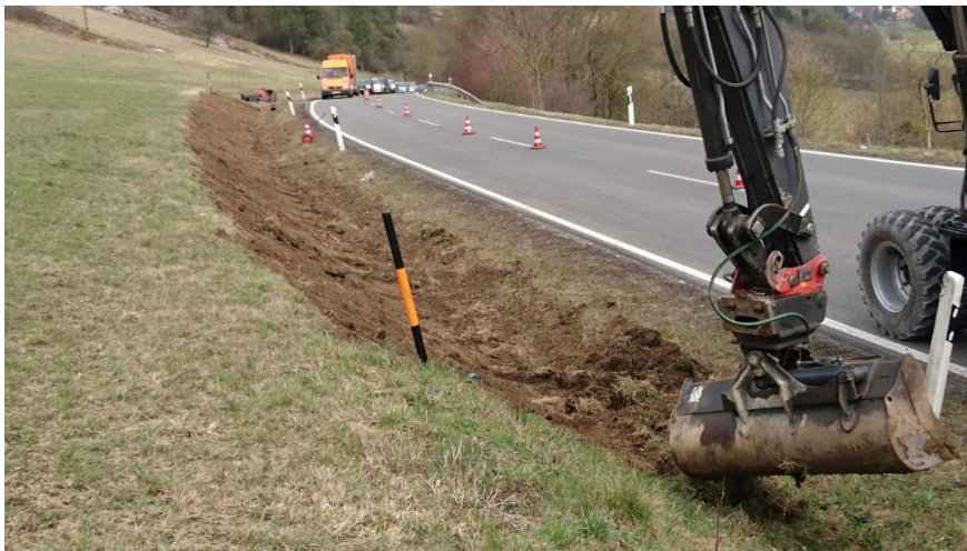
Foto 10 Abziehen des Oberbodens mit Verkehrssicherungsmaßnahmen; Foto: Straßenmeisterei Künzelsau
